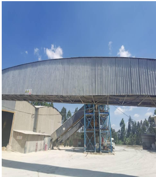
封闭的物料输送线
