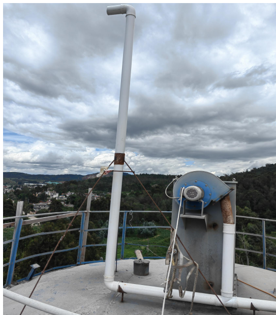
细粉料筒仓呼吸粉尘排气筒1#
