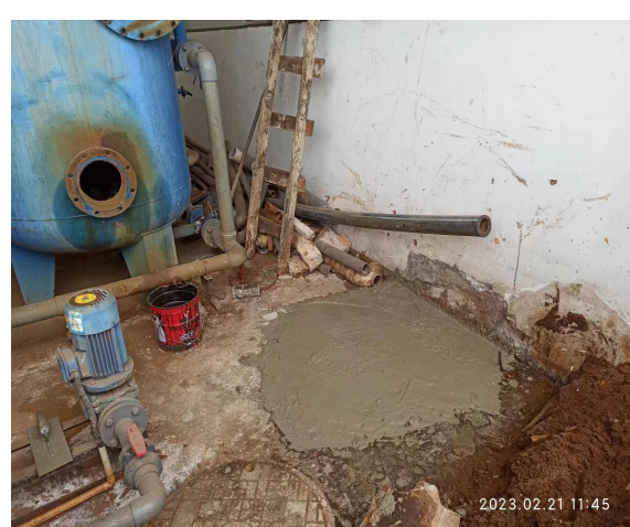
工业废水排口封堵后
