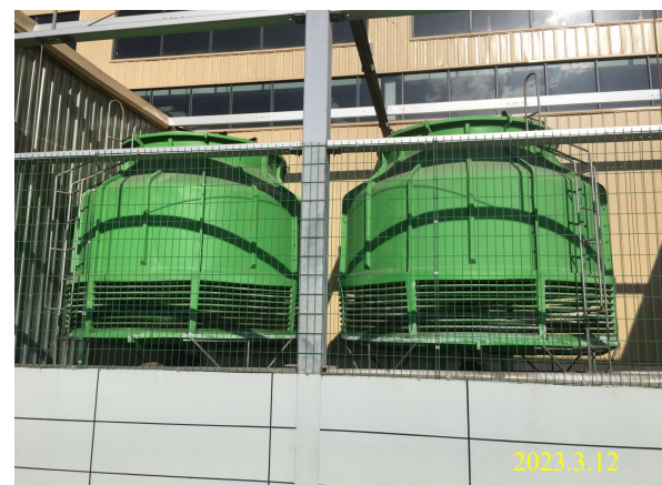
依托利用循环水池
