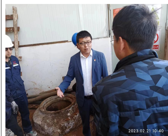
工业废水排口封堵前
